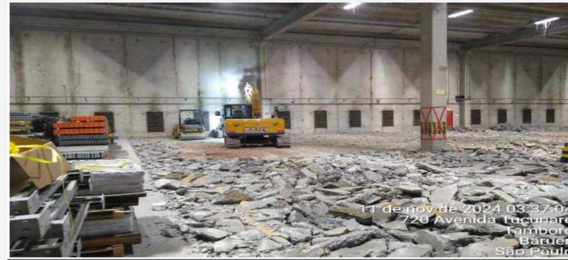
11/11 - Demolição da segunda parte do piso industrial
