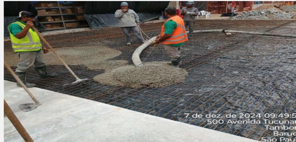
07/12 - Concretagem da segunda placa
