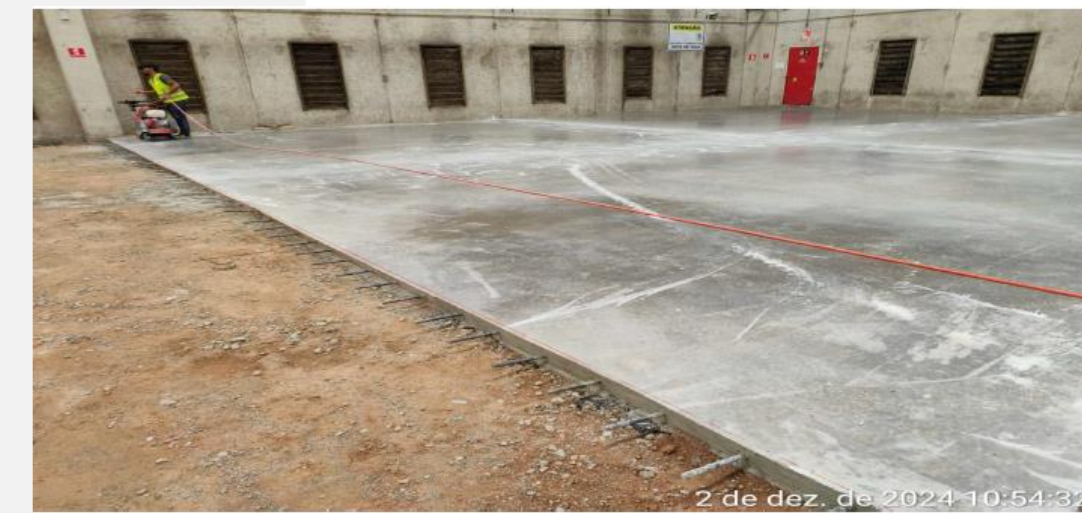
02/12 - Concretagem da primeira placa executada
