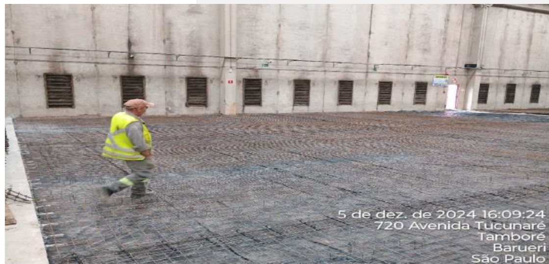
05/12 - Montagem parcial da terceira placa
