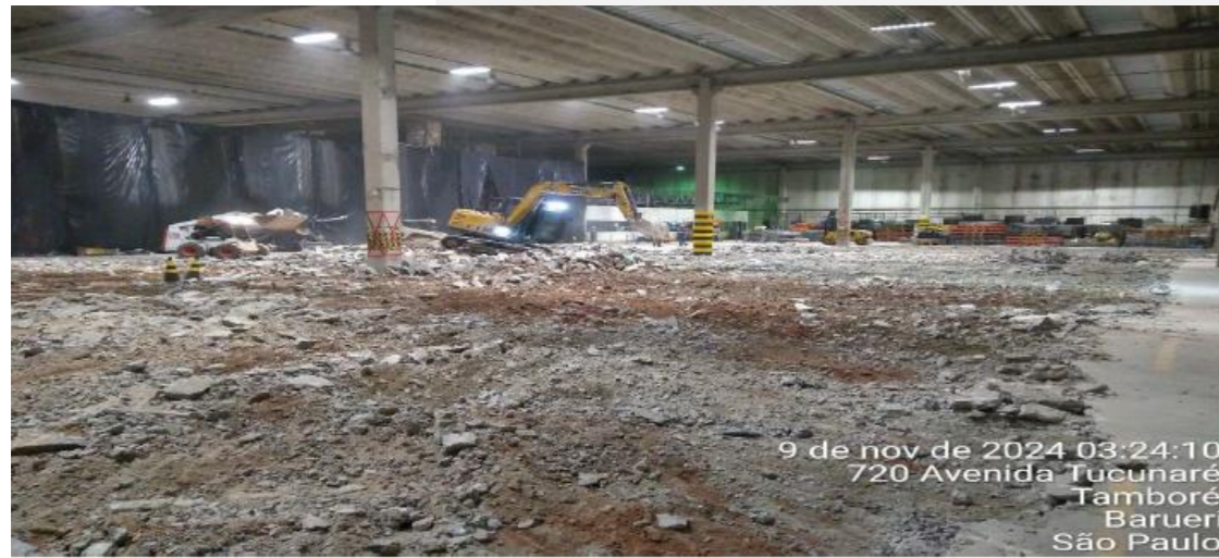
09/11 - Movimentação e transporte do entulho
